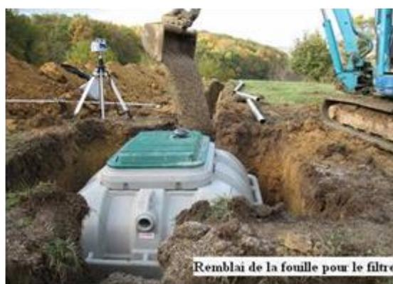
*Autres exemple d'installation d'ANC avant et après remblai*
