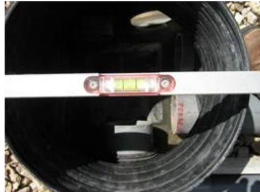
*Vérification de la collecte des effluents et mesure de l'horizontalité sur un regard de visite*
